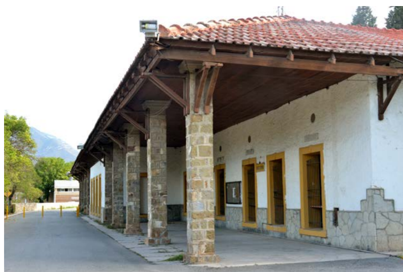
Arriba: fachada de La Gloria. Abajo: Patio exterior.
